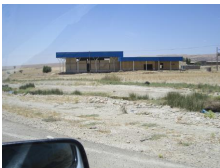
شکل (۶): تصاویری محل احداث
