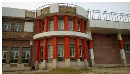
شکل (۶): تصاویری محل احداث
