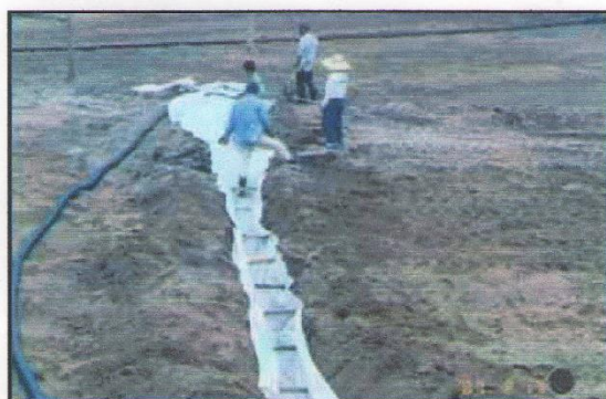
قرار دادن لوله تملیه در کف استخر
