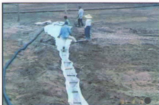
قرار دادن لوله تفلنیه در کف استخر
