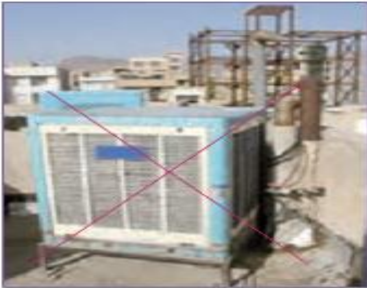
ب - فاصله بین دودکش تا کولر آبی و یا دریچه های تأمین هوای ساختمان دست کم سه متر باشد.
