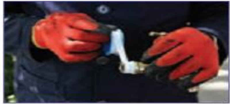
ب - پیچیدن نوار تفلون روی شیر تو
