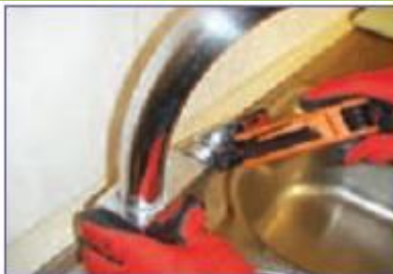
ب- باز کردن دسته شیر با آچار آلن
