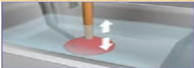
ب - حرکت عمودی لوله بازکن
