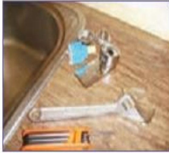
ح- اطمینان از سالم بودن قطعات و تعویض مغزی
