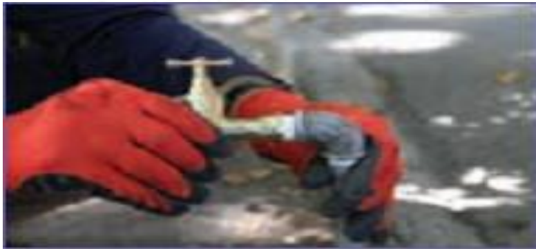
ت - بستن شیر با دست به لوله
