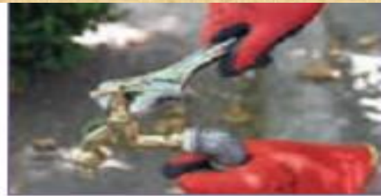
چ - بستن کلگی شیر ابتدا با دست و سپس محکم کردن آن با آچار
