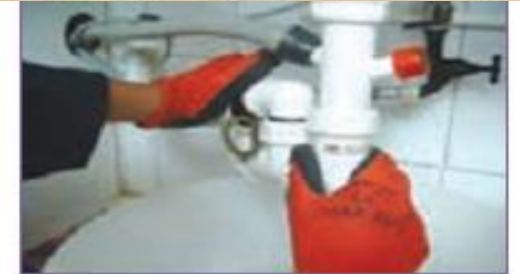
الف - قرار دادن ظرف زیر سیفون و باز کردن آن
