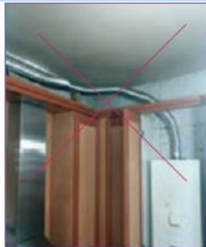
ح - هرگز از لوله‌های خرطومی به جای لوله رابط دودکش استفاده نکنید.
