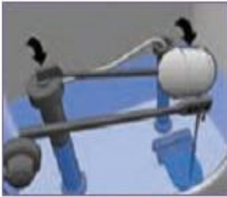
ت - اطمینان از بستن آب ورودی توسط شناور در زمان پر شدن مخزن
