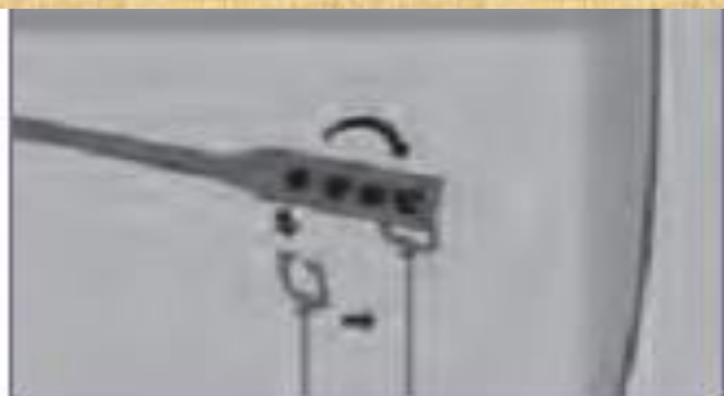
ح - اطمینان از محکم بودن اتصال زنجیر و تنظیم طول آن
