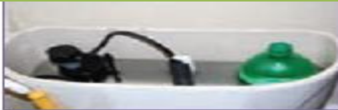
ب - قرار دادن یک بطری پر شده از آب در فلاش تانک کل ۱۲-۶ - دو روش صرفه جویی در مصرف آب برای فلاش تانک
