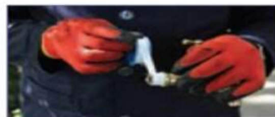
ب - پیچیدن نوار تفلون روی شیر نو
