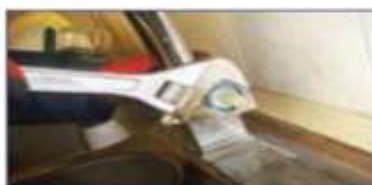
ت - باز کردن پیچ روی مغزی (گلتند)
