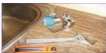
ح - اطمینان از سالم بودن قطعات و تعویض مغزی
