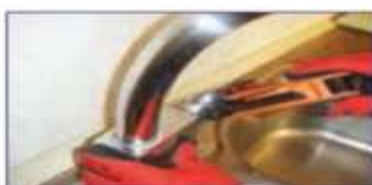
ب - باز کردن دسته شیر با آچار آلن
