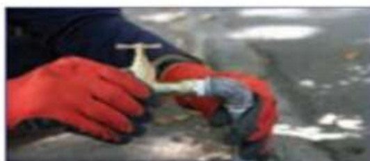
ت - بستن شیر با دست به لوله
