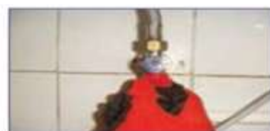
الف - تست شیر های آب گرم و سرد پیسوار زیر کاسه
