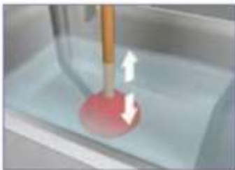
ب - حرکت عمودی لوله بازکن
