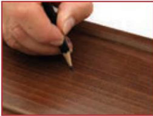
ب - مشخص کردن مرکز در با مداد
