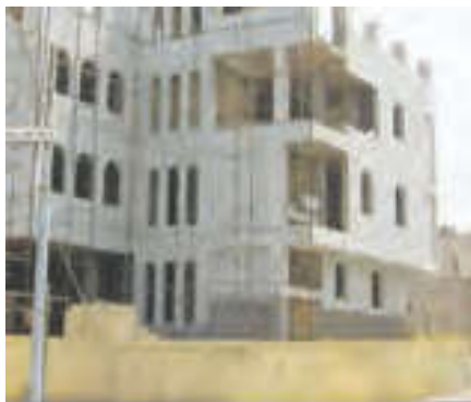
فلز آهن + فولاد + بتن
