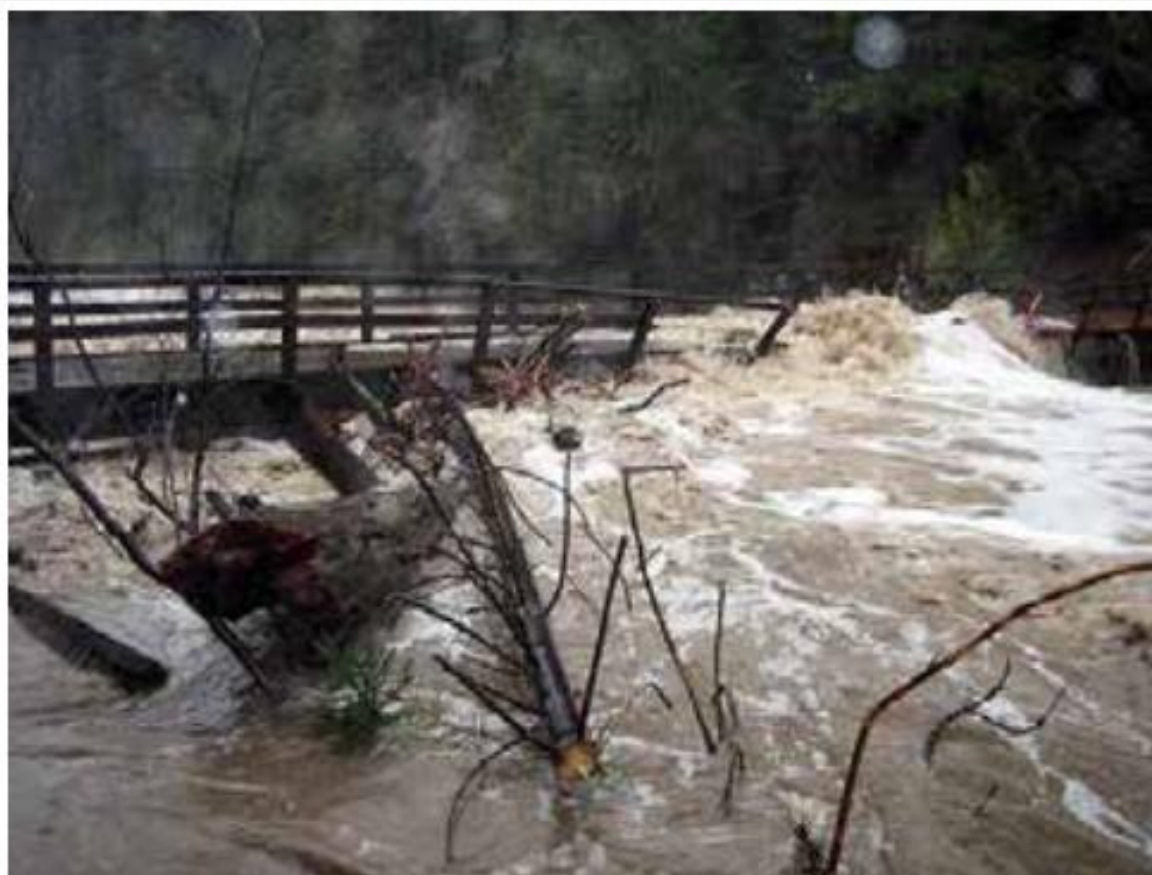
مسدود شدن دهانه پل در اثر سیلاب توسط تنه و شاخ و برگ درختان موجب سر ریز شدن سیل و تخریب پل می شود
