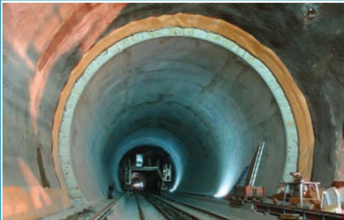
شکل ۴-۶- پوشش داخلی تونل به وسیله قطعات بتن
