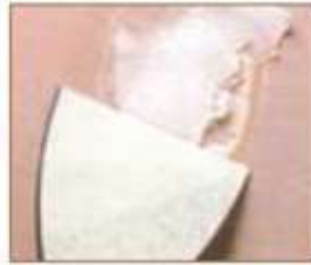
ب - لکه گیری و ترمیم ترک ها
