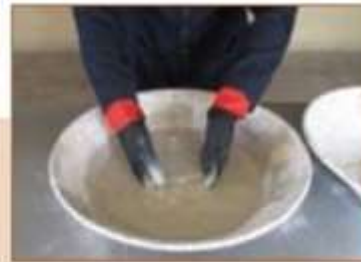
ت - مخلوط کردن گچ و آب با هم زدن آن‌ها
