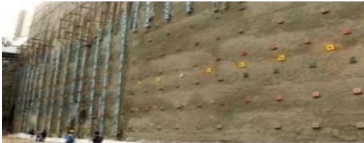
پایداری سازی شیب به روش میخ کوبی
