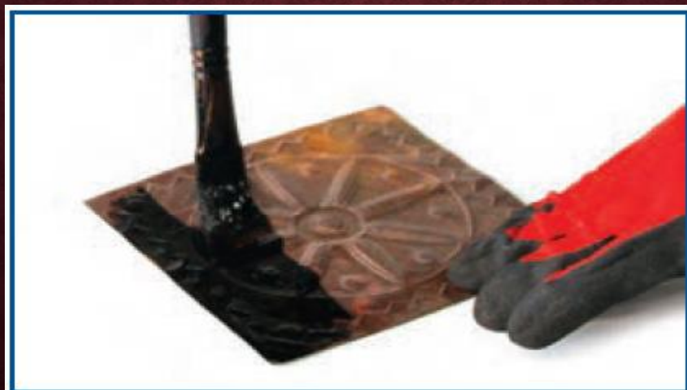
شکل ۱۰-۱۰- آغشته کردن سطح پلاک مسی به قیر
