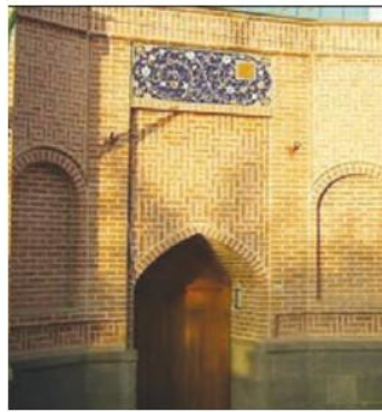
شکل ۳ - نمونه‌هایی از ساختمان‌های مسکونی استمکام متوسط - زیرا در سافت آن آجر به کار رفته است
