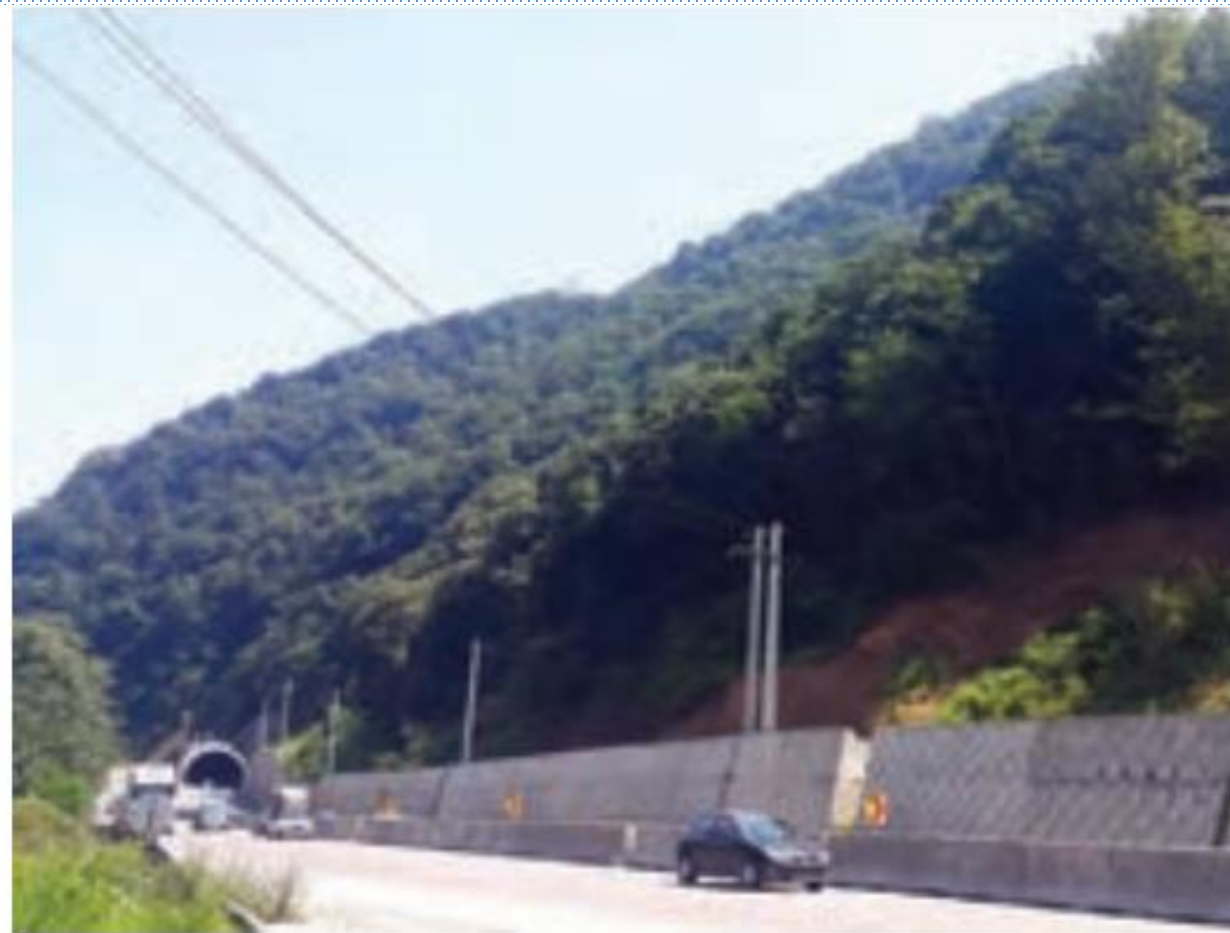
نصب حفاظ بتونی - جاده قائم شهر
