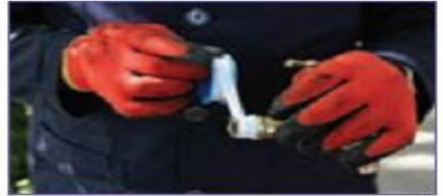
ب - پیچیدن نوار تفلون روی شیر تو
