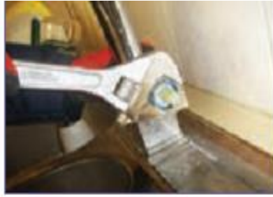
ت- باز کردن بیج روی مغزی (گلند)
