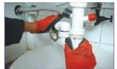
الف - قراردادن ظرف زیر سیفون و باز کردن آن
