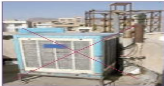
ب - فاصله بین دودکش تا کولر آبی و یا دریچه‌های تأمین هوای ساختمان دست کم سه متر باشد.
