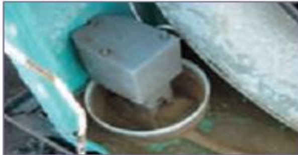
ج - بررسی و تمیز کردن پمپ آب
