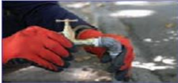
ت - بستن شیر با دست به لوله
