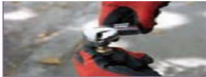
ج - جایگزینی واشر آب بندی و سفت کردن آن
