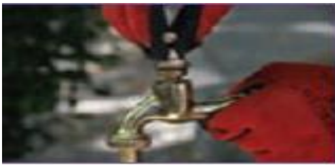
ب - باز کردن کلگی شیر با آچار در جهت باد ساعتگرد ت - ادامه باز کردن کلگی شیر با دست
