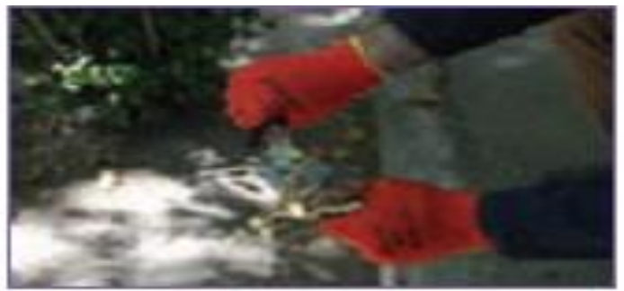
ب - باز کردن کلگی شیر با آچار در جهت باد ساعتگرد ت - ادامه باز کردن کلگی شیر با دست
