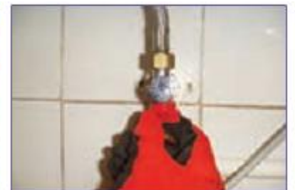
الف - بستن شیرهای آب گرم و سرد پسوار زیر کاسه
