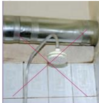
ت - عبور دودکش از داخل حمام یا سقف کاذب آن مجاز نیست.
