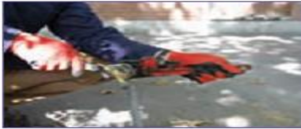
ب - باز کردن شیر با دو آچار (به جهت انداختن آچارها توجه کنید.)
