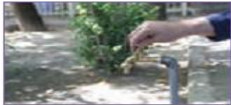
خ - آزمایش آب بندی شیر
