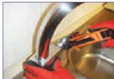
ب - باز کردن دسته شیر با آچار آن
