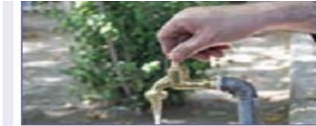
ج - آزمایش نهایی شیر آب (پس از باز کردن شیر اصلی)
