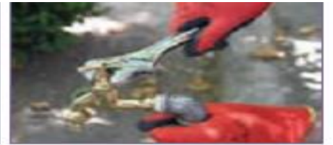
ج - بستن کلگی شیر ابتدا با دست و سپس محکم کردن آن با آچار
