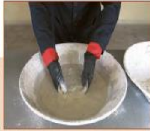
ت - مخلوط کردن گچ و آب با هم زدن آن‌ها
