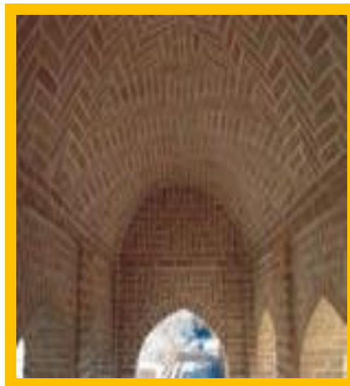
استفاده از آجر برای سقف قوسی
