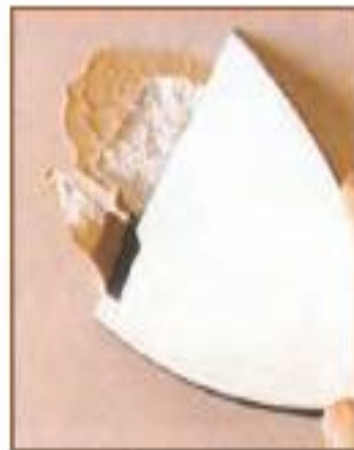
الف - باز کردن ترک‌ها
